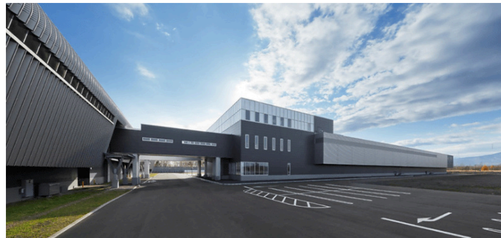
さくらインターネット 石狩データセンター(3号棟)
